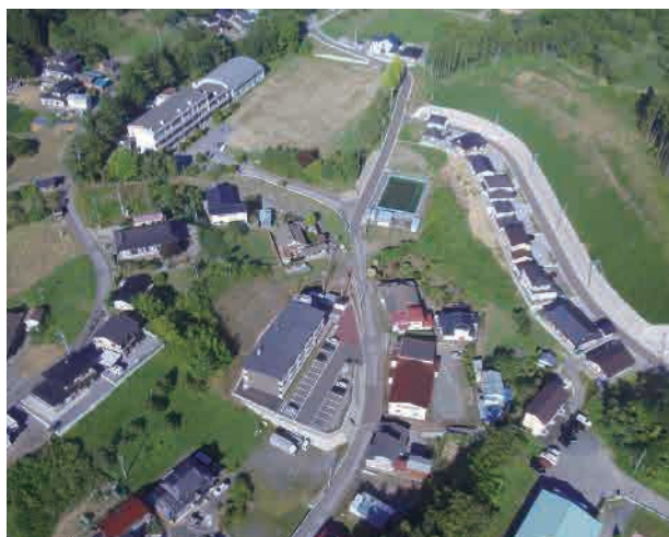
■蛸ノ浦地区の防災集団移転団地
