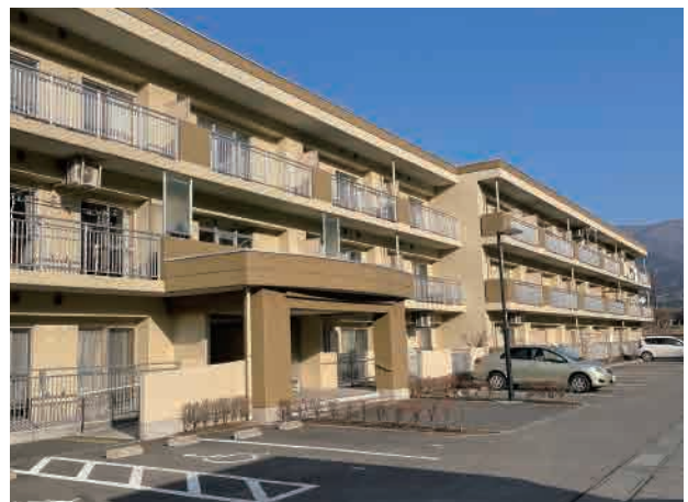
■災害公営住宅 下欠東アパート
