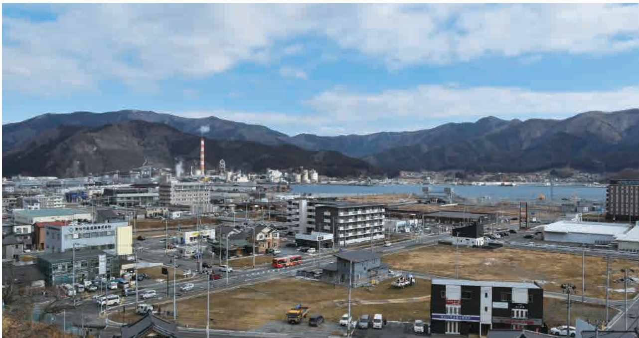
■商業施設や住宅の建設が進む中心市街地
