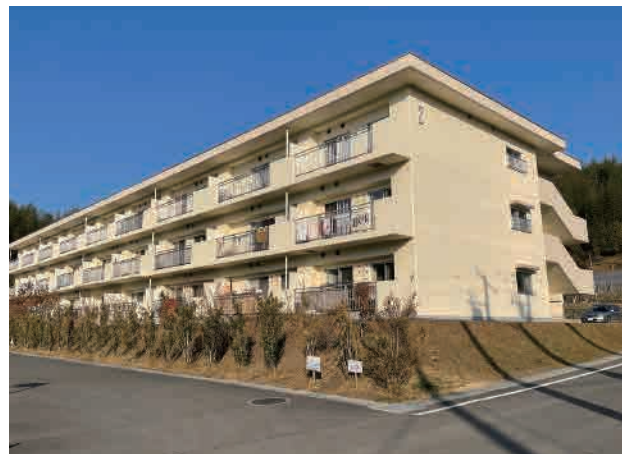
■災害公営住宅 長谷堂東団地
