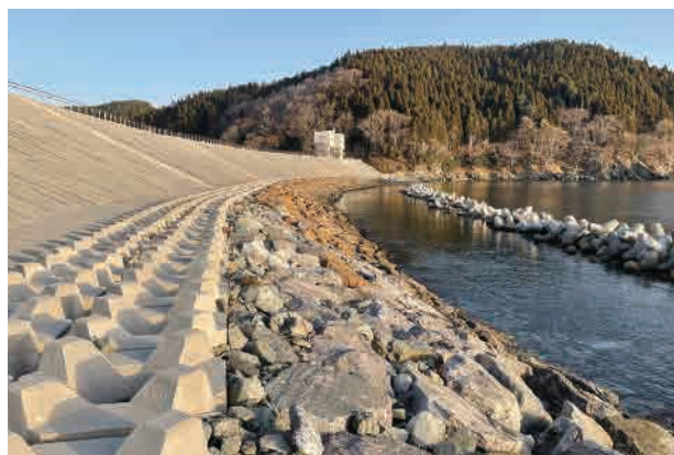
■石積みとした甫嶺地区の防潮堤
