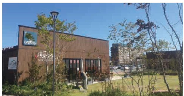
■キャッセン・モール&パティオ内の湾岸食堂
