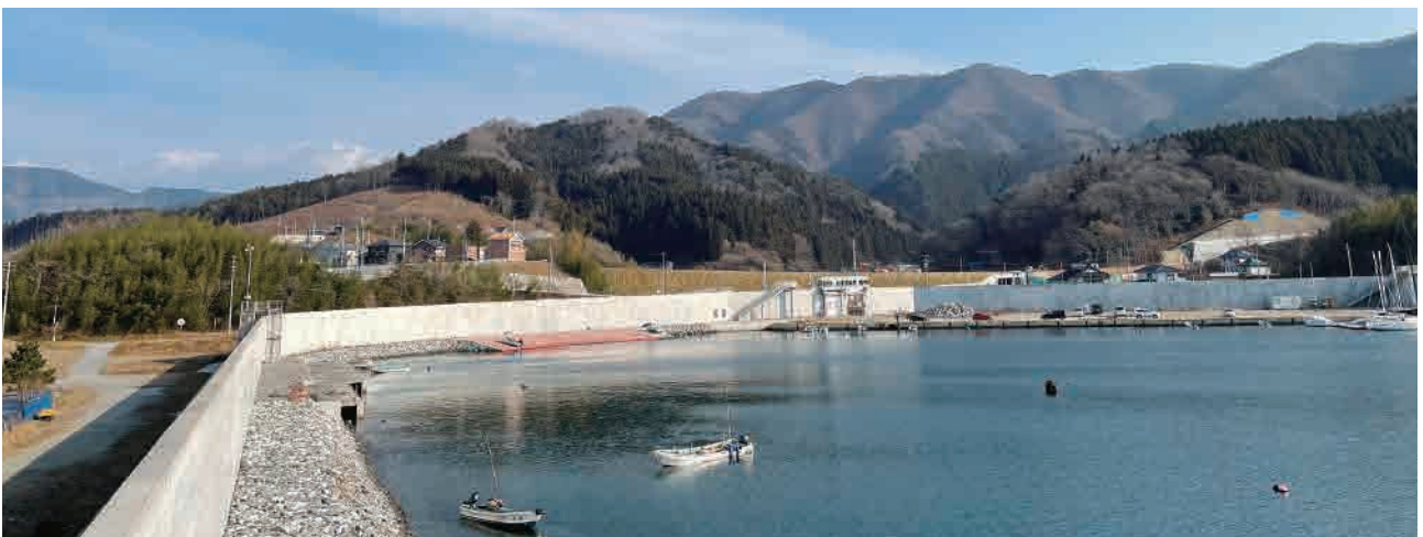
■防潮堤が整備された永浜地域
