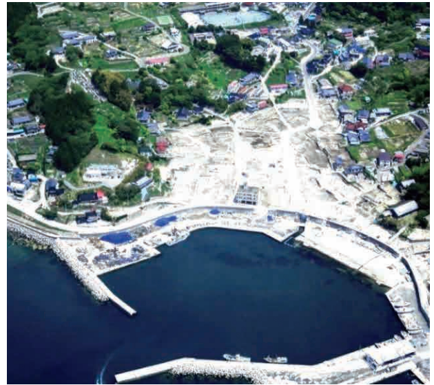
■復旧前の崎浜漁港
