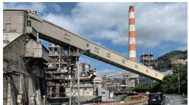
■ 早期に再建稼働した工場
