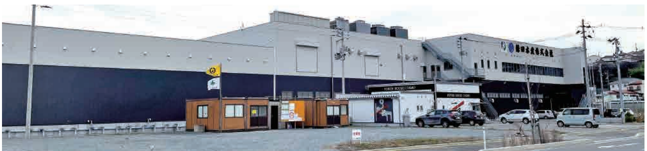
■ 中心市街地に再建した水産事業者(大船渡町)
