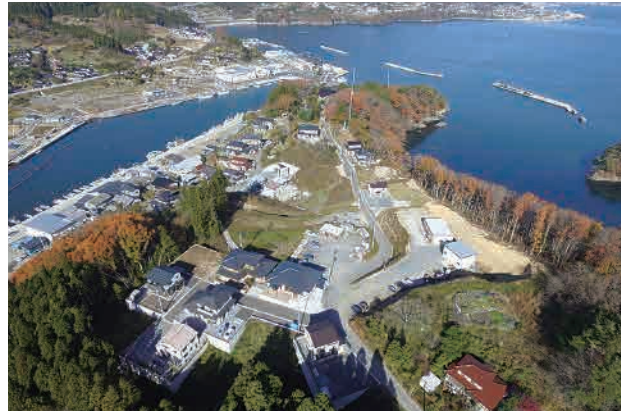
■差込型の防災集団移転住宅団地(末崎町神坂地区)
