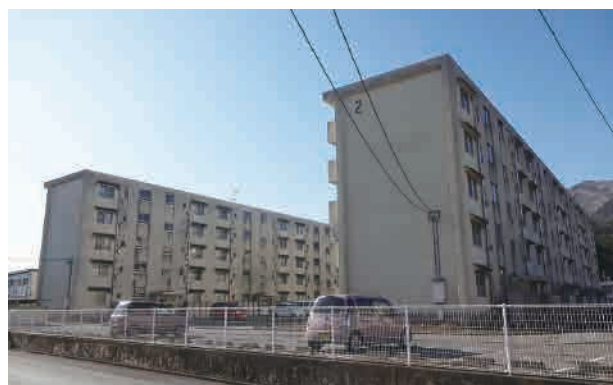
■早期供用開始した災害公営住宅 盛中央団地
