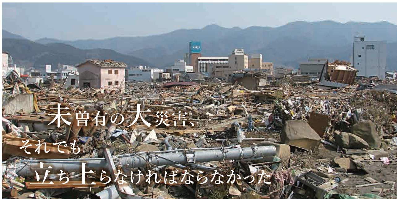
■被災直後の大船渡駅周辺地区
