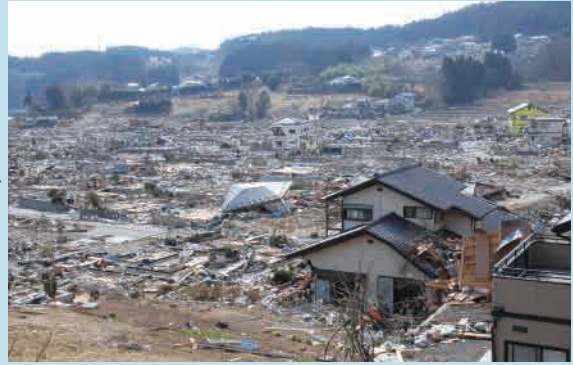
■多くの家屋が流失した大田団地
