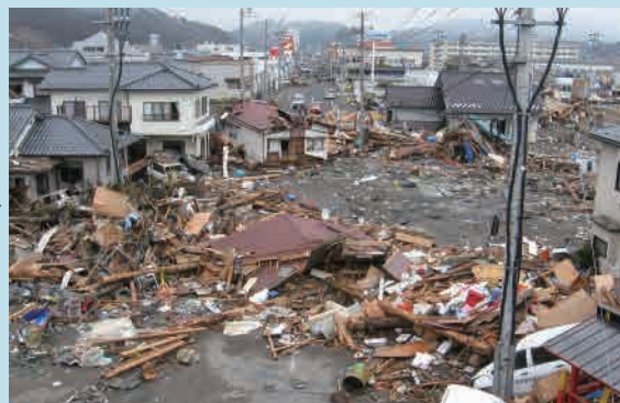
■ガレキが散乱した県道(下館下地内)
