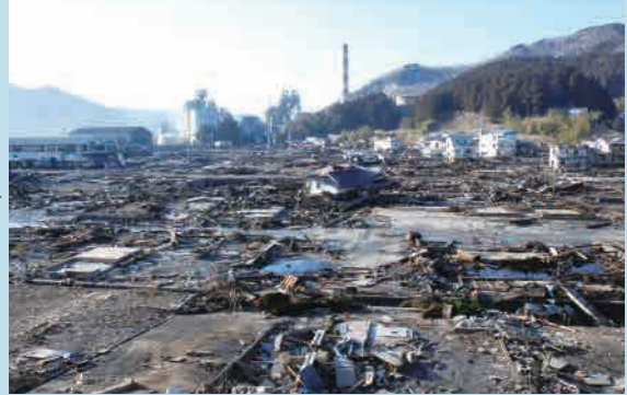
■津波により一面がガレキと化した生形地内
