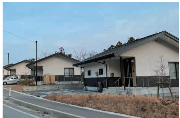
■「りあすの丘」の災害公営住宅 泊里団地
