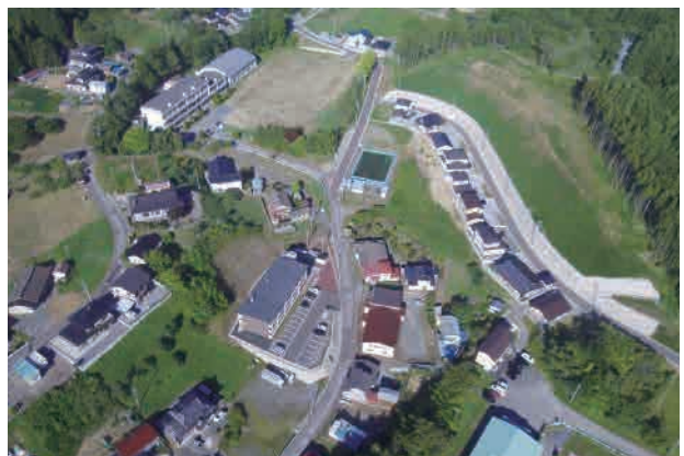
■蛸ノ浦地区の防災集団移転団地
