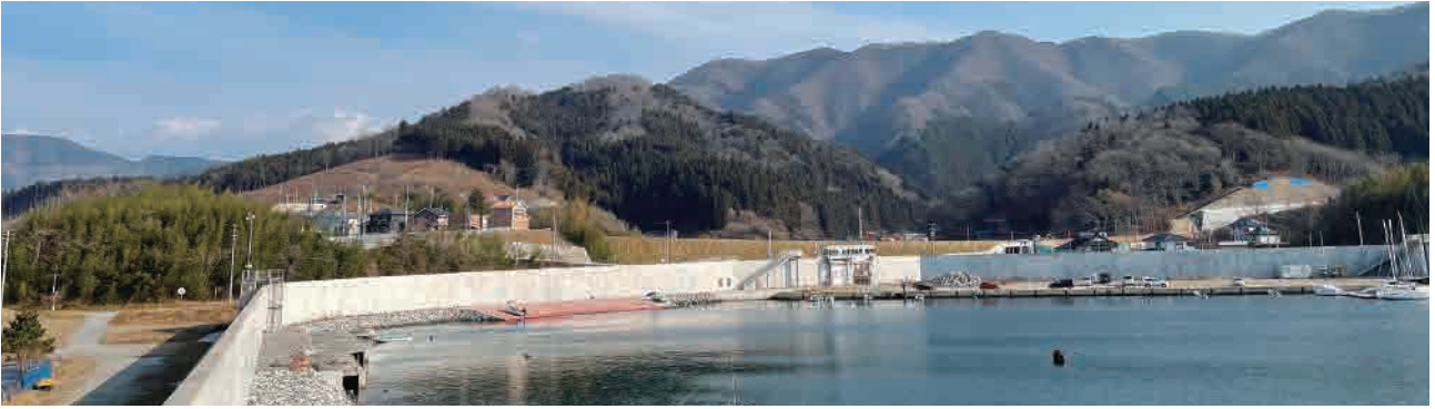
■防潮堤が整備された永浜地域
