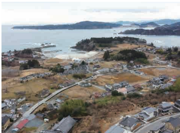
■住宅の高台移転や防潮堤復旧工事が完了した泊里地区
