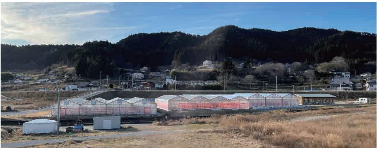
■イチゴ生産・担い手育成拠点施設
