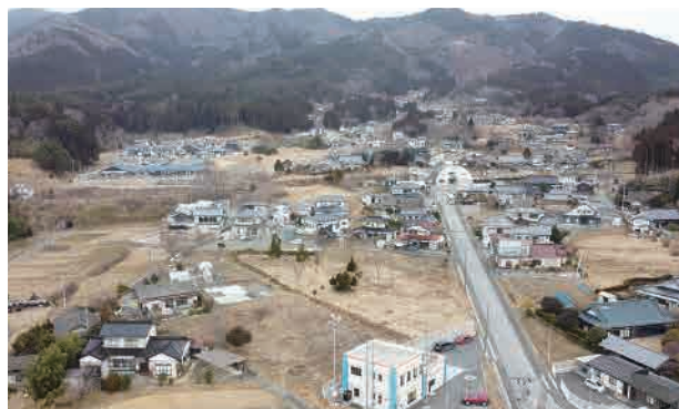
■高台に防集団地が整備された三陸鉄道綾里駅周辺
